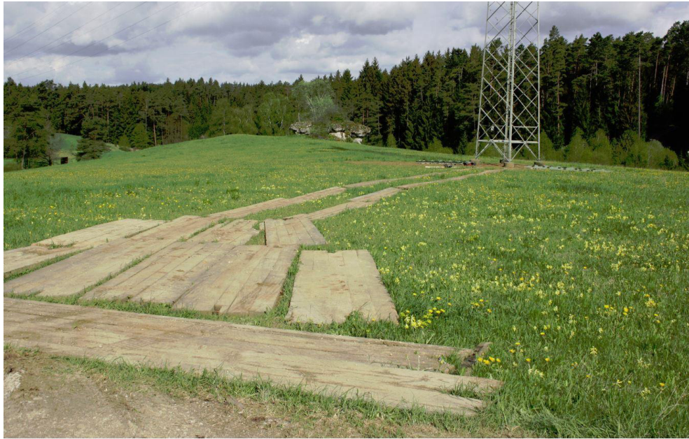
Abbildung 17: Zuwegung über Holzplatten (leichter Wegebau)
