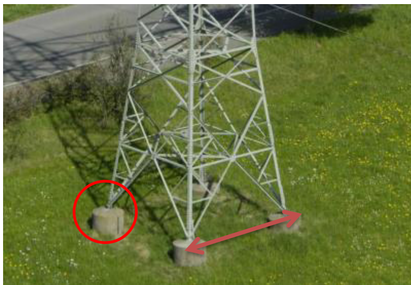
Abbildung 7: Sichtbare Betonfundamentköpfe und Bodenaustrittsmaß
