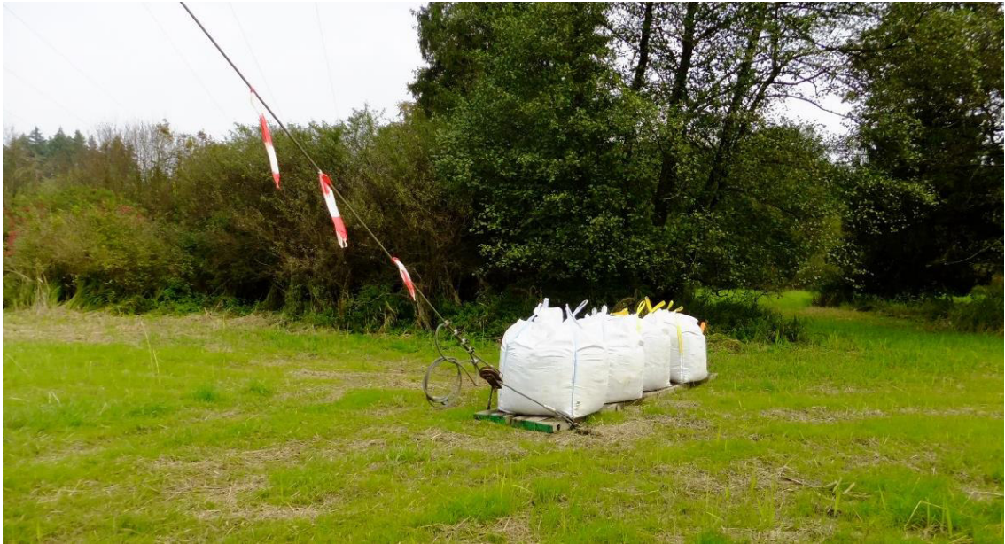
Abbildung 19: Abankerung mittels Ballastschlitten
