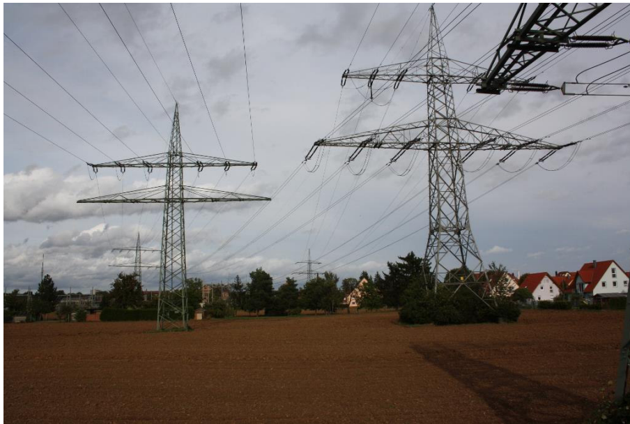
Abb. 3: Ltg. Nr. Ü22, Mast Nr. 2 (links im Bild, geplant Ersatzneubau am gleichen Standort), Ltg. Nr. B88 Mast Nr. E14 (rechts im Bild, geplant Fundamentverstärkung und Erhöhung um 4 m) sowie im Vordergrund Ltg. Ü23, Mast Nr. S1 (geplant: Anbau Traverse, ohne Eingriffe in den Boden). Aufnahme 13.09.2017.
