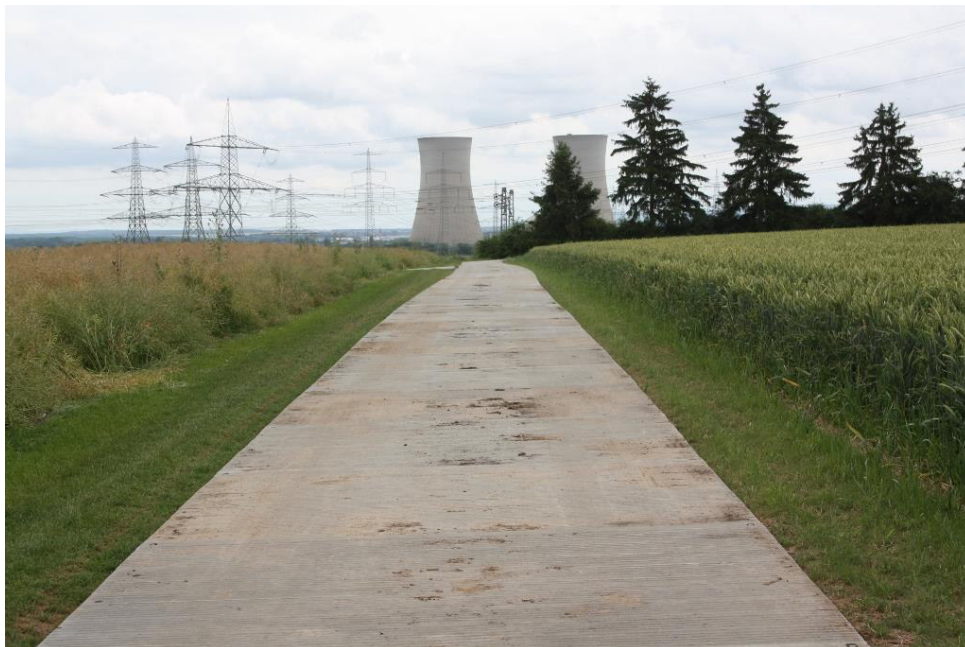
Abbildung 16: Zuwegung über Aluplatten (schwerer Wegebau)
