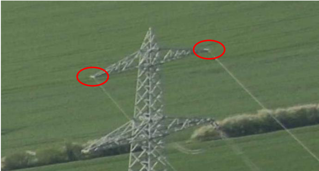
Abbildung 13: Mastspitze mit zwei Blitzschutzseilen
