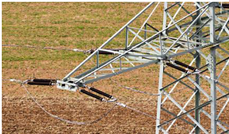
Abbildung 15: Abspannketten
