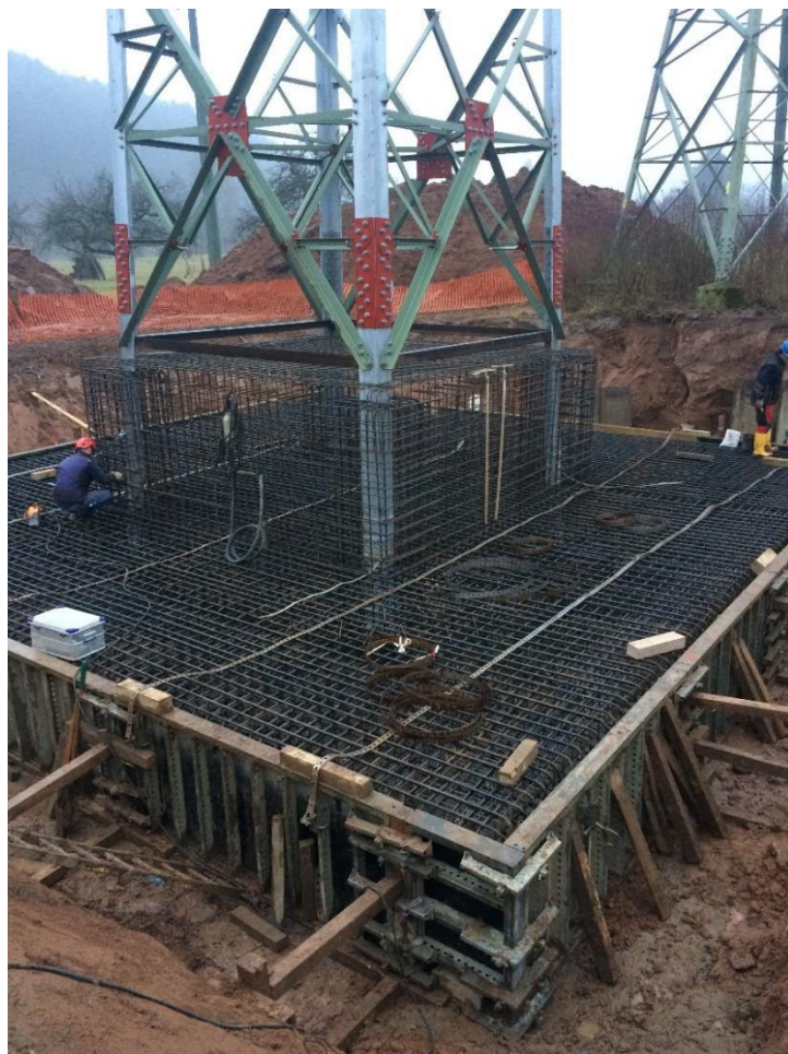
Abbildung 18: Beispiel für Fundamentarbeiten, Schalung und Bewehrungsstahl
