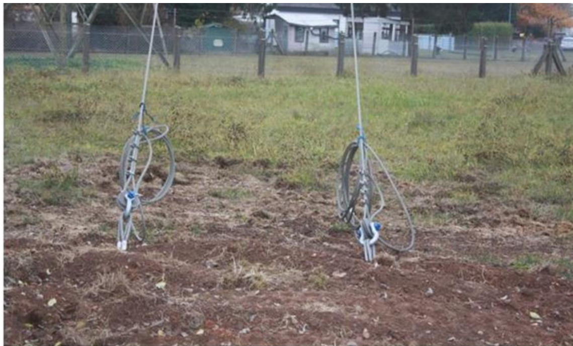
Abbildung 20: Ins Erdreich eingebrachte Anker
