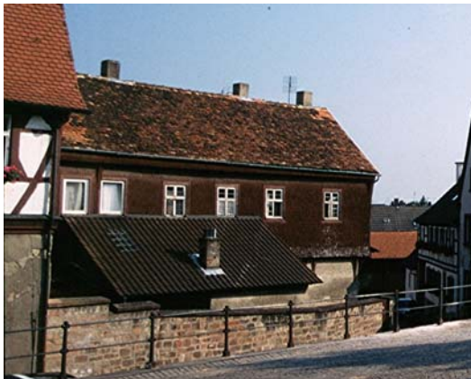
Zustand vor der Sanierung
