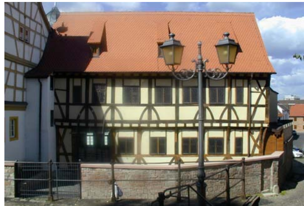
Gotisches Haus nach der Sanierung
