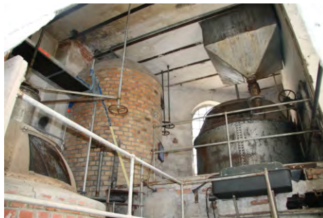
ehem. Brauerei vor Sanierungsbeginn
