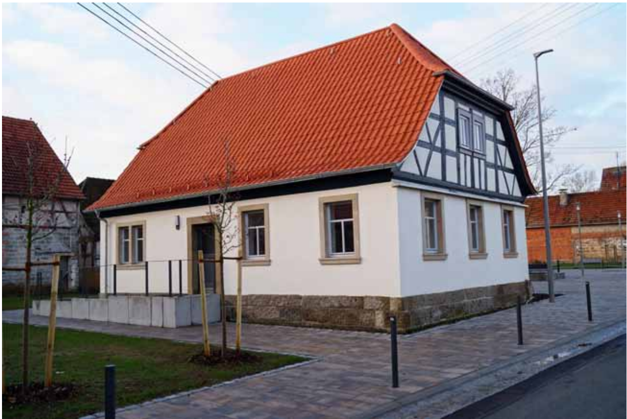
Saniertes Fachwerkgebäude mit Jugendraum und Dorfplatz
