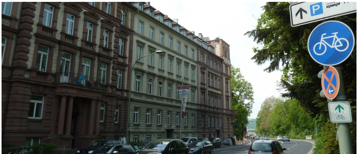
Abbildung 18. Blick auf den Untersuchungsabschnitt Röntgenring in Würzburg [13].
