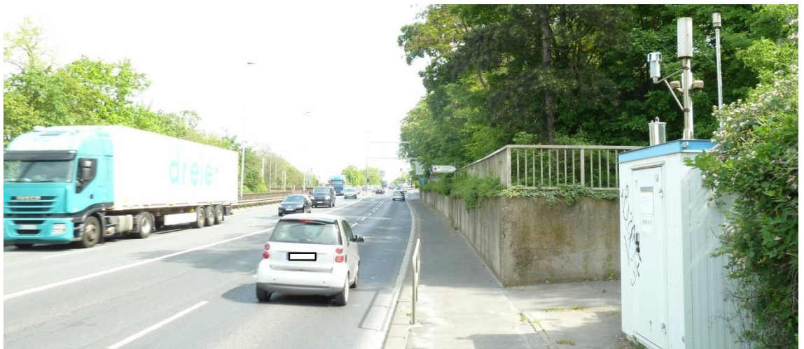
Abbildung 4. Blick auf den LÜB-Messcontainer Stadtring Süd in Würzburg, Richtung Südwesten (oben) und Richtung Nordosten (Mitte und unten) [13].
