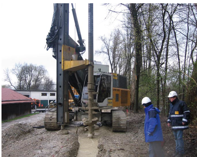
Oben: Überströmung einer Dichtwand an der Iller in Fischen während des Hochwassers 2005; Unten: Einbau einer Dichtwand als tiefeichende Bodenvermörtelung (Hochwasserschutz Mangfall)
