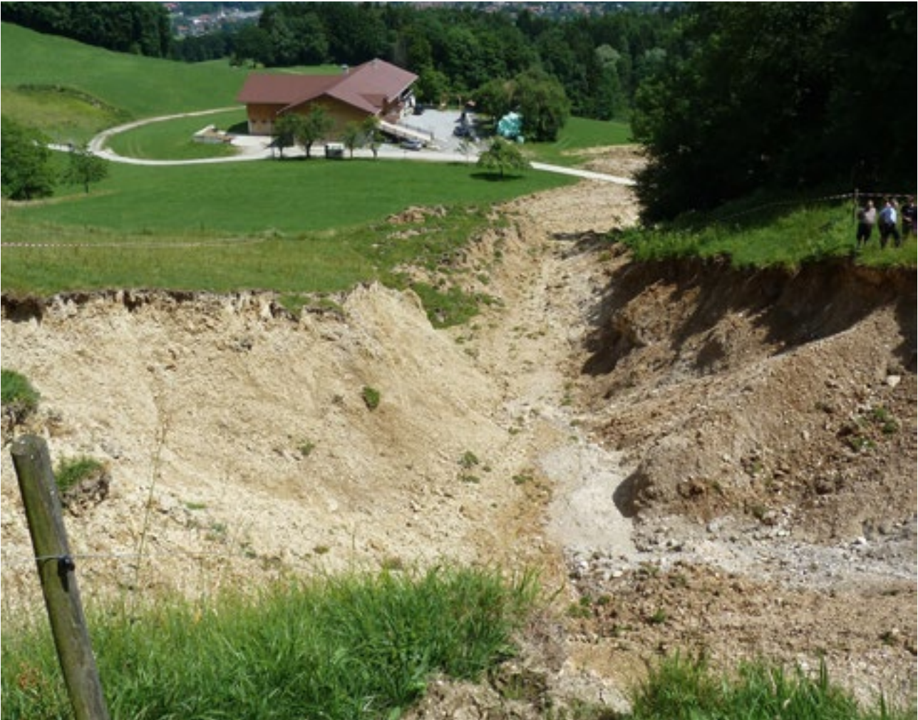
Abbildung 4.14_9: Hanganbruch bei Aich (Brannenburg) infolge Starkregenereignissen im Juni 2013
