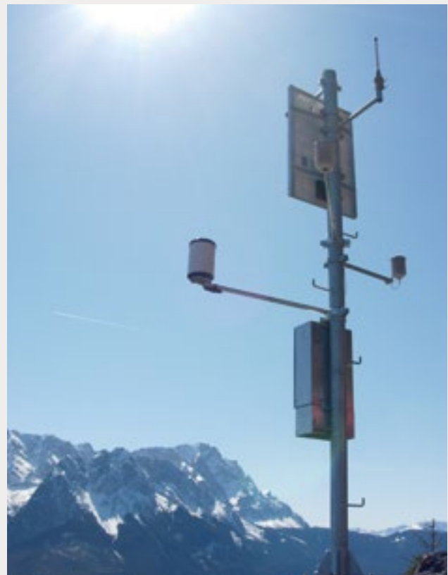
Abbildung 1: Eine von vier neu installierten Klimastationen
