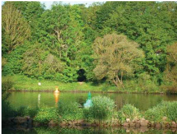
Foto Nr. 3: Gehölzbestand am Eisenbahndamm bei Durchlass Hauptstraße 39/41.
