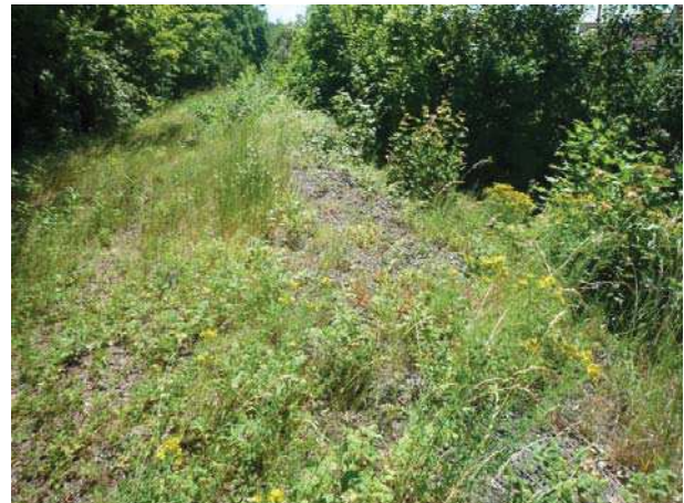
Foto Nr. 6: Dammkrone mit offenen, besonnten Schotterbereichen und seitlichem Gehölzbewuchs.
